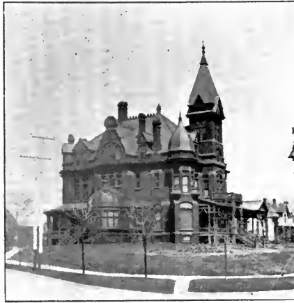
J. B. Greenhut's Wohnhaus. (J. B. Greenhut's residence.)
